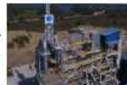
(例) 廃棄物発電施設
